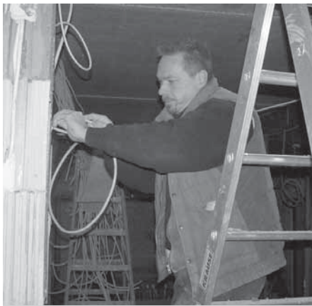
Der Herr der Kabel - Andreas - immer schwer auf Draht.
